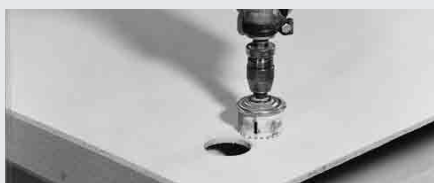
Découper à la scie cloche (pose d'un boîtier électrique)
