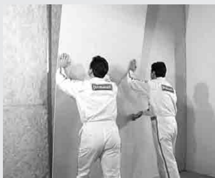
Pose d'un parement sur une ossature métallique
