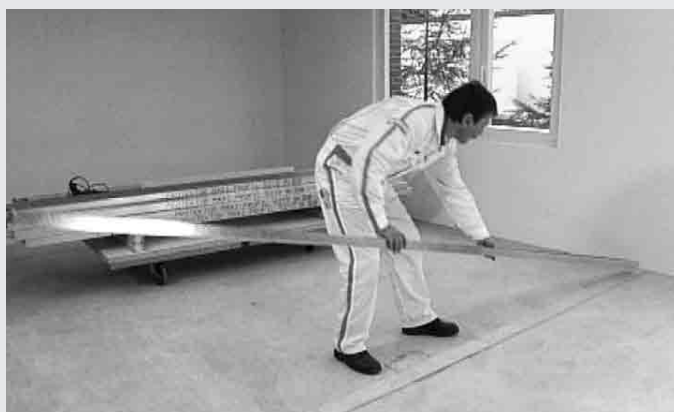
Pose des profilés de rive en U sur le sol avec interposition d'une bande isolante
