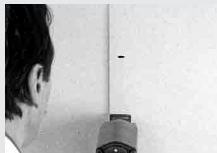
Agrafage plaque sur plaque fermacell
