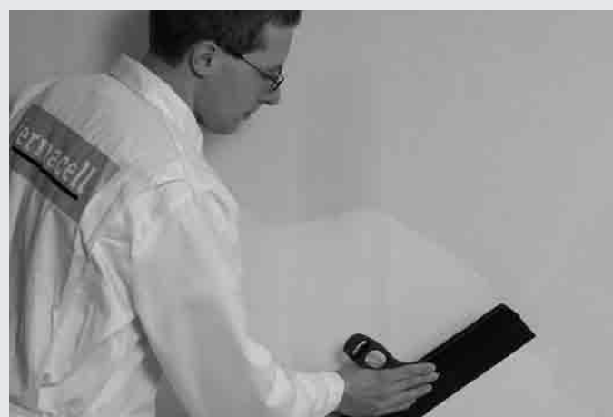
Surfaçage à l'aide de l'Enduit de lissage fermacell ou de l'Enduit de surfacage fermacell
