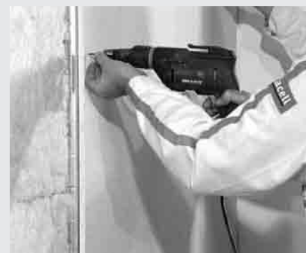
Fixation du parement par vis autoperceuses
