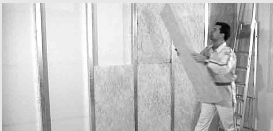
Pose de plaques isolantes
