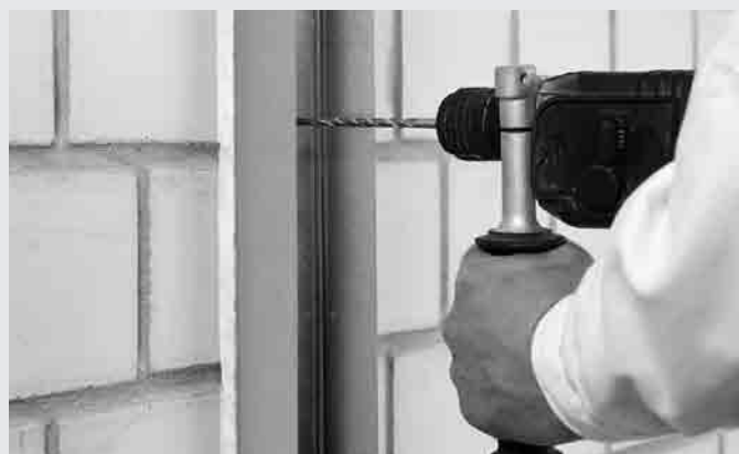
Fixation des profilés verticaux sur un mur plein avec interposition d'une bande isolante
