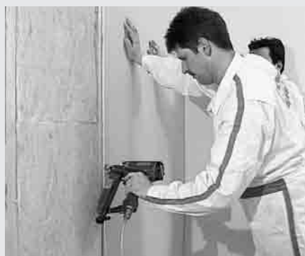
Pose d'un parement sur une ossature bois par agrafage sous un angle de 30 degrés (agrafe : largeur du dos 1 cm, Ø 1,5 cm et longueur \pm 3 \times l'épaisseur).
