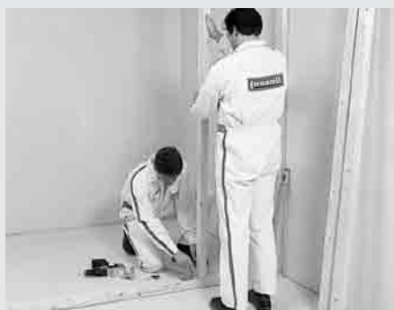
Pose des montants en bois avec fixation par clous ou équerres
