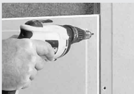
Vissage sur ossature métal
