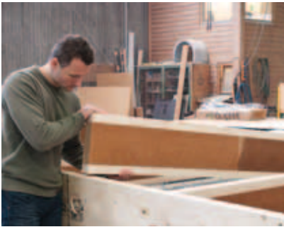
Préfabrication d'éléments de mur avec STEICO LVL R et STEICOWall.
