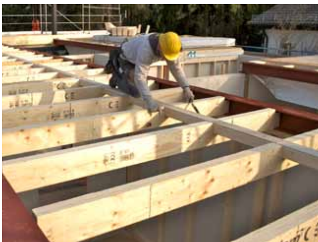
Construction de structure porteuse de plafond avec STEICO LVL R.
