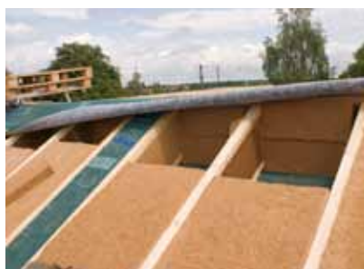
Vue de l'isolation de la toiture. Poutres préisolées STEICO joist avec panneaux isolants STEICO flex .
