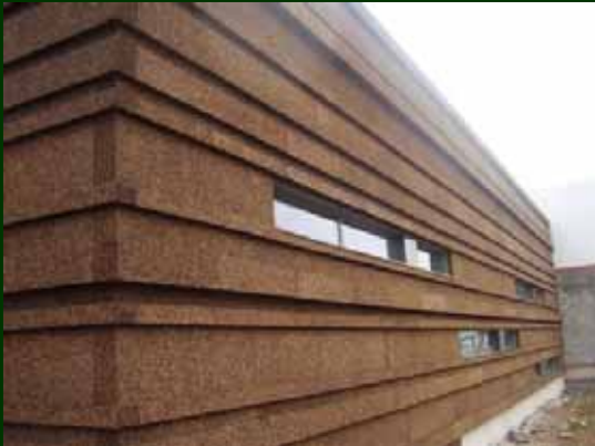
Cellier Logadega (Évora) (pmc arquitectos)
