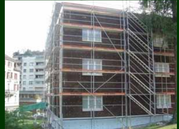
Isolation de murs extérieurs
