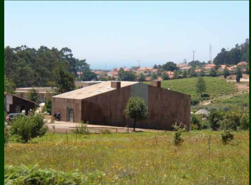
Maison privée à Esposende (Arch. Vasco Magalhães)
