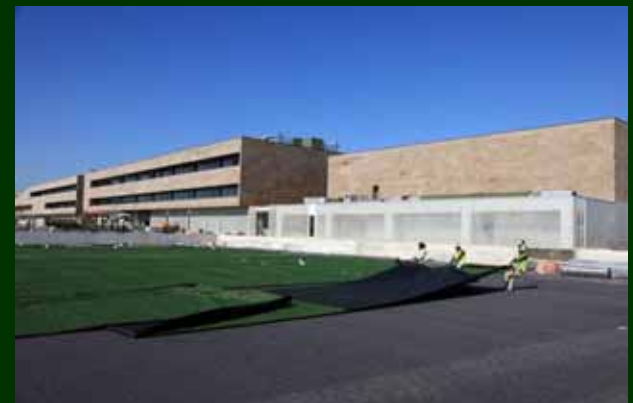
École Pedro Arrupe (GJP Arquitectos)
