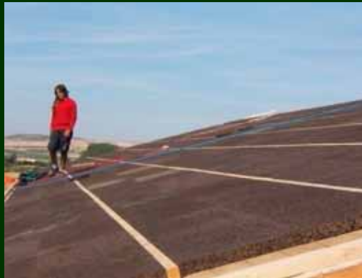
Isolation de toiture
