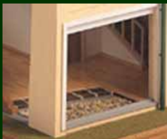
Isolation thermique sous le plancher
