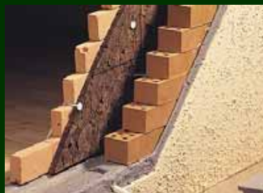
Isolation de cavités
